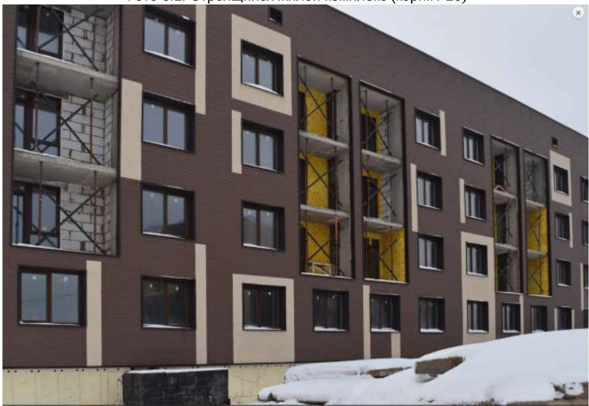
Фото 6.2. Строящийся жилой комплекс (корп.№11)
