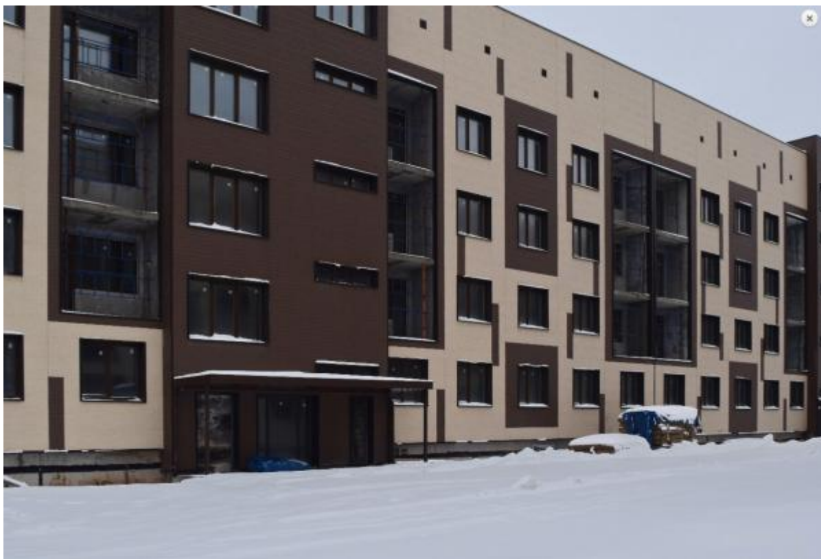
Фото 6.5. Строящийся жилой комплекс (корп.№14) 1
