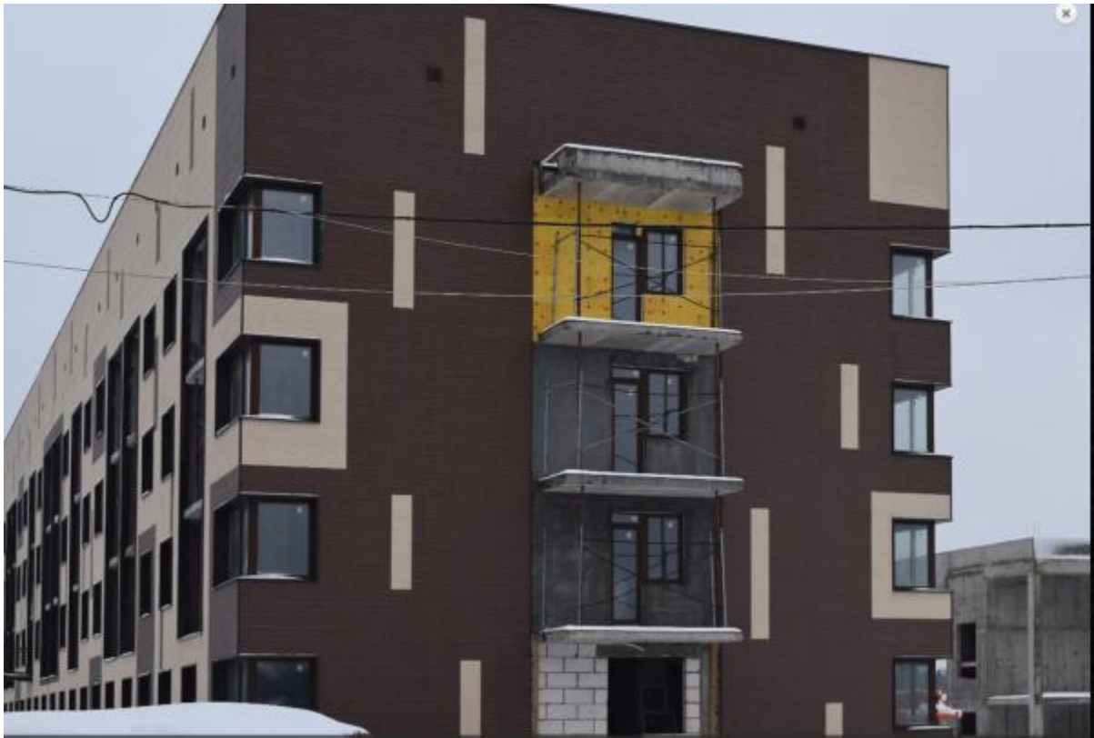
Фото 6.1. Строящийся жилой комплекс (корп.№10)
