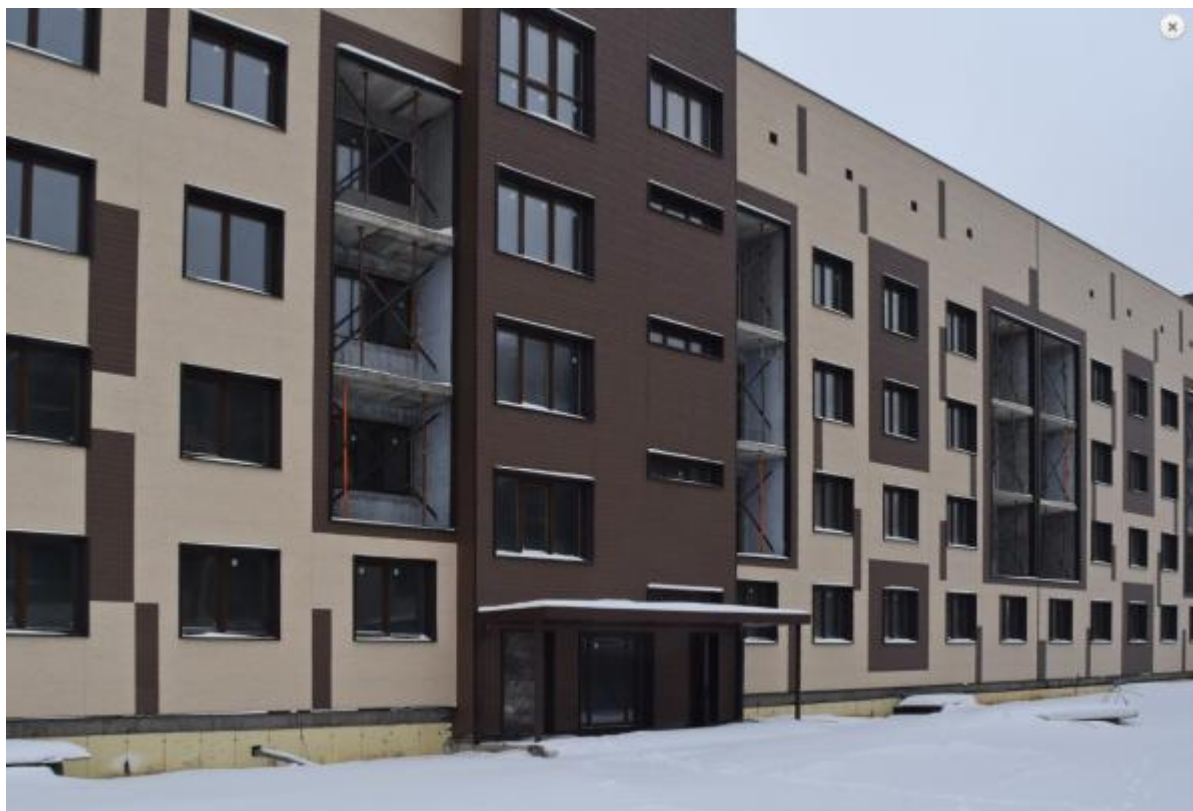
Фото 6.3. Строящийся жилой комплекс (корп.№12)
