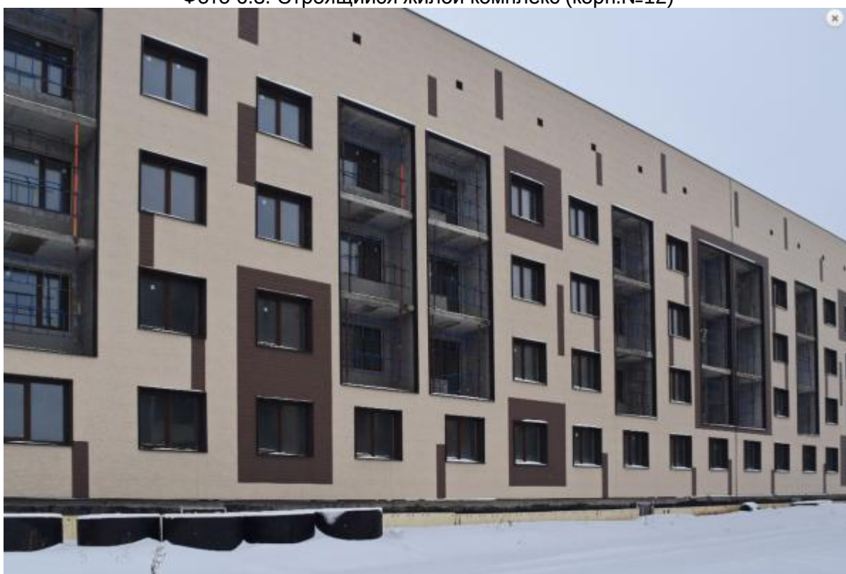
Фото 6.4. Строящийся жилой комплекс (корп.№13)
